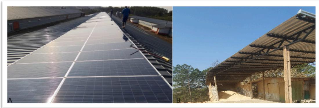
Legenda: A - placas solares na cobertura de um dos aviários que usadas como fontes de energia para iluminação, B - depósito de pellets que são utilizados como combustível na caldeira de aquecimento.
